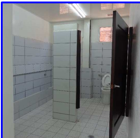
Apreciar vista interna de servicio sanitario de varones en el Gimnasio de Boxeo, donde se aprecia la instalación de cielo falso, lámparas, aparatos sanitarios y puertas de madera.
