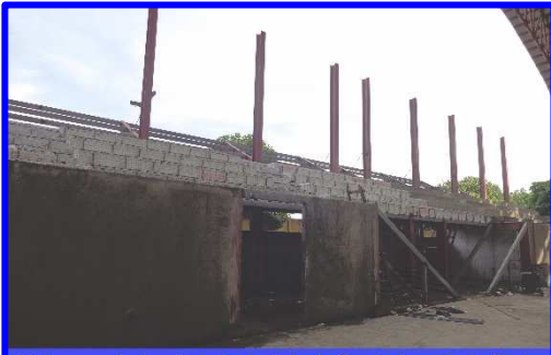
Vista panorámica de fachada Este de Gradería costado Oeste, donde se aprecia la ejecución de las etapas de estructura metálica y covintec de la gradería, paredes de covintec.
