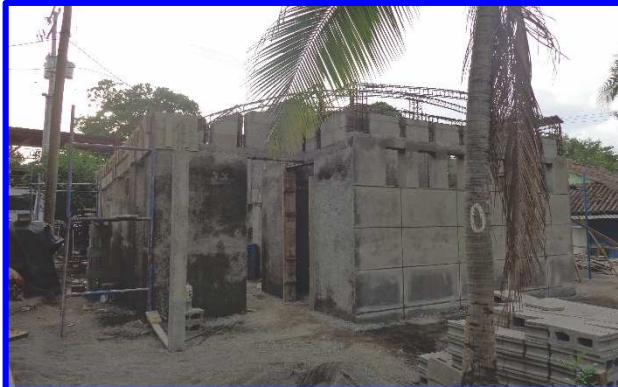
Vista panorámica de la construcción del edificio de servicios sanitarios; apreciar la ejecución de las etapas de estructura de concreto, mampostería y acabados (repello y fino en paredes).
